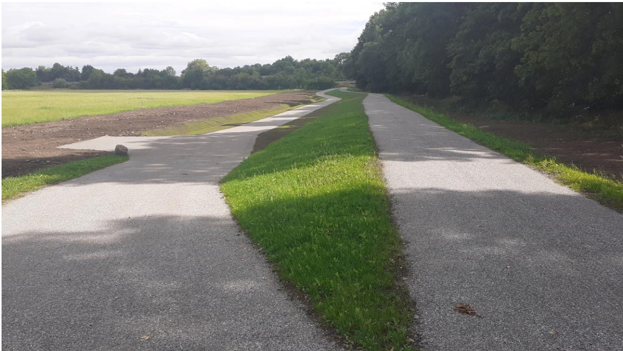
Abbildung 1 – Fertig gestellter Deich in Blickrichtung BAB 36
