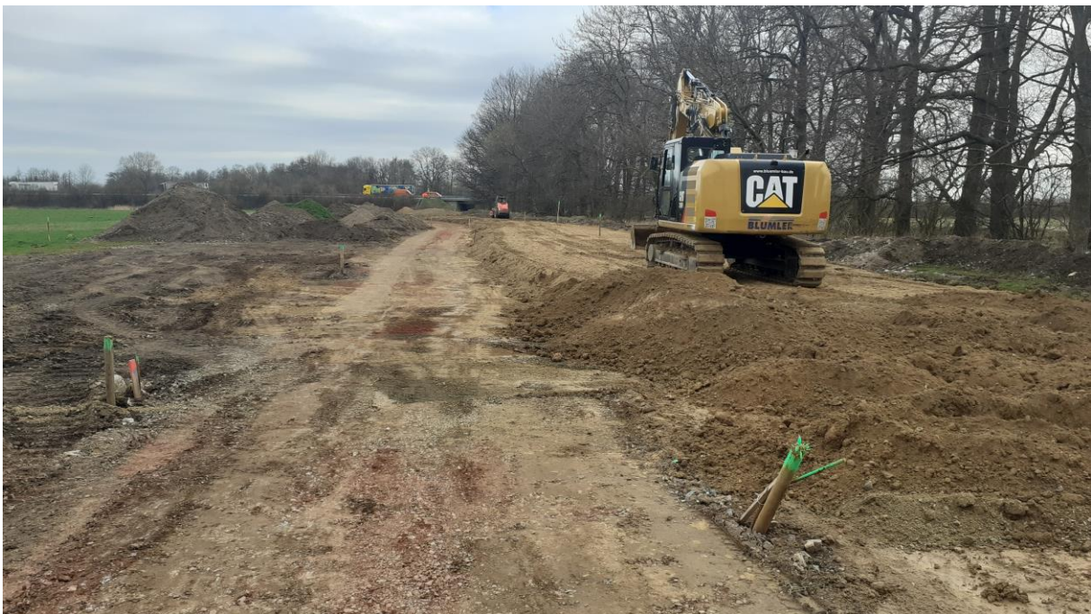
Abbildung 2 - Deich im Bau; Aufbau des Stützkörpermaterials
